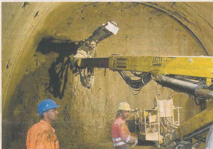
Die Löcher für den Sprengstoff werden etwa 1,50 Meter tief gebohrt.
