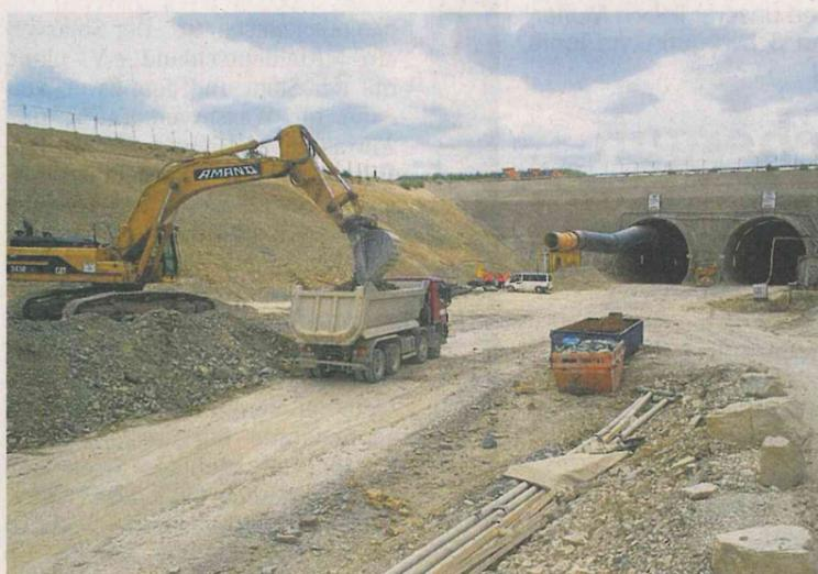
Der Ausbruch wird vor den Tunneln gelagert und dann abtransportiert.
