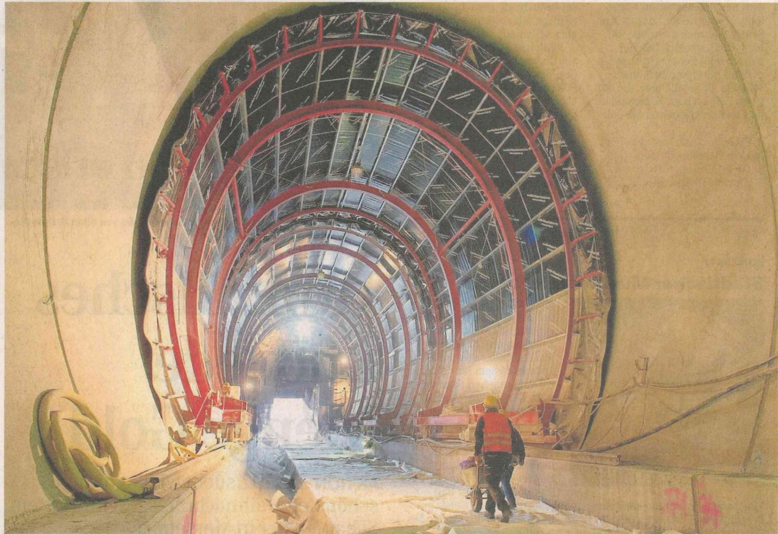
Die Beton-Innenschalen der Tunnelröhren sind fertig, die letzte Schalung wird demnächst fallen.
