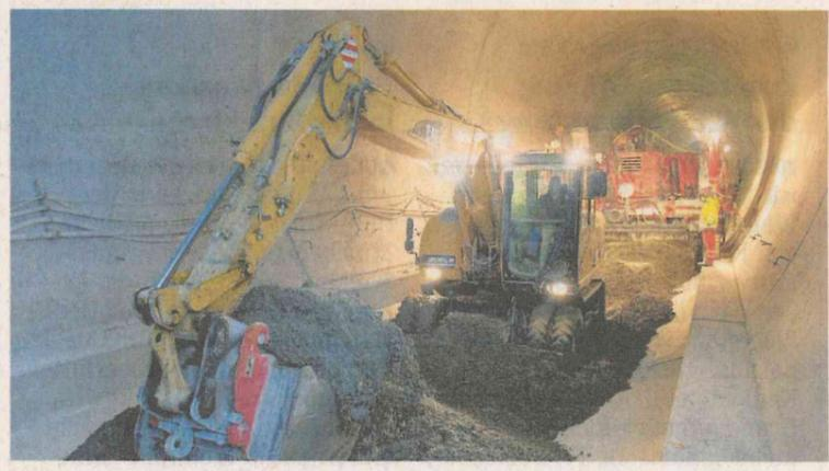
Derzeit werden im Tunnel 10 000 Kubikmeter Sohl-Beton eingebracht.
